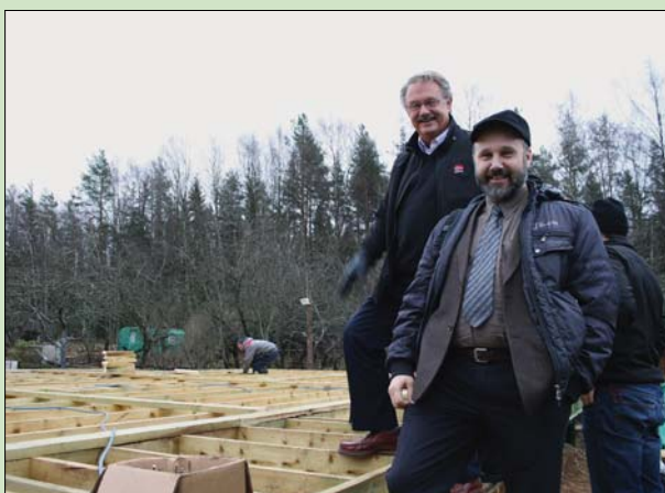
Pastor Valera sammen med Jon Teigen ved nyehuset. Nå er det kommet under tak, og snart flytter de inn.
